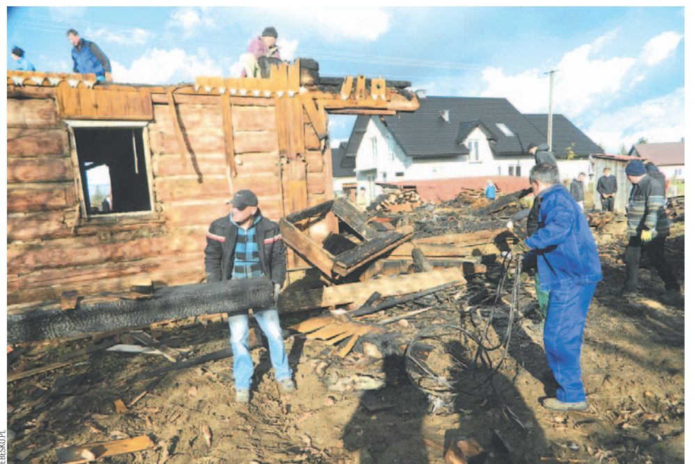
Spalony dom nadawał się tylko do rozbiórki
