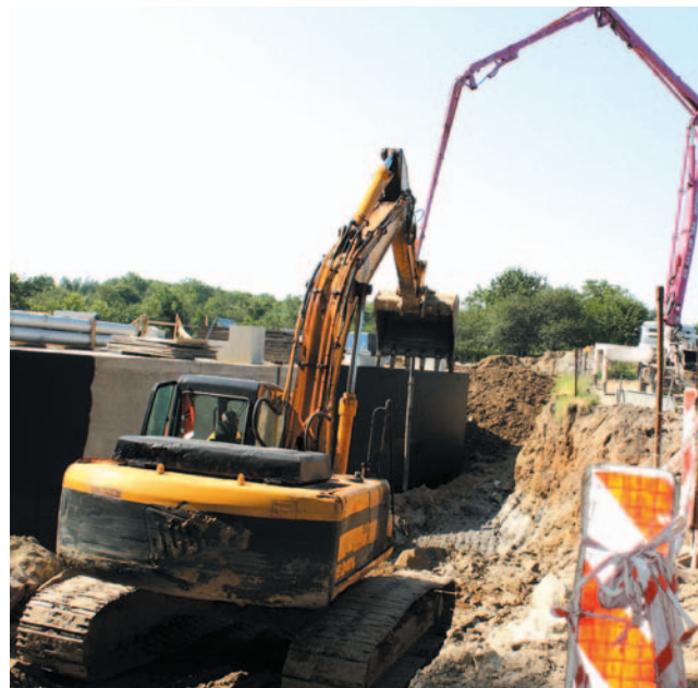
W 2012 r. Intrabet wybudował dwa potężne zbiorniki wyrównawcze przy ul. Kenara
