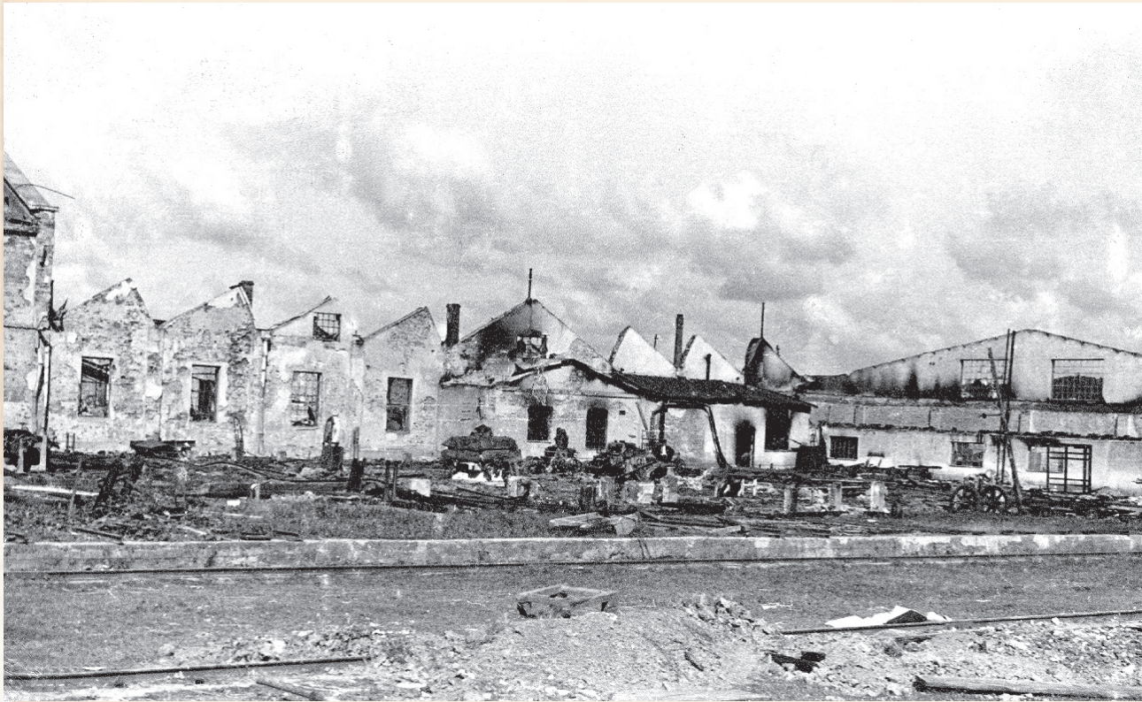
Zniszczona Fabryka Wagonów w 1945 r.
