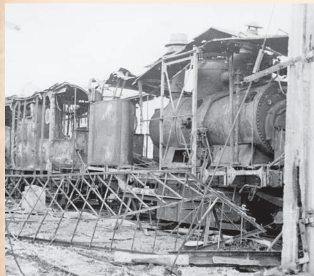
Zniszczona Fabryka Wagonów w 1945 r.
