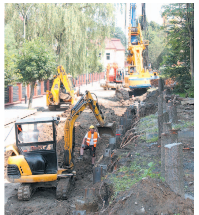
Roboty zabezpieczające osuwisko od strony północnej w 2014 roku, w sąsiedztwie Bursy Szkolnej. Teraz trzeba zabezpieczyć najwyższe partie Góry Parkowej
