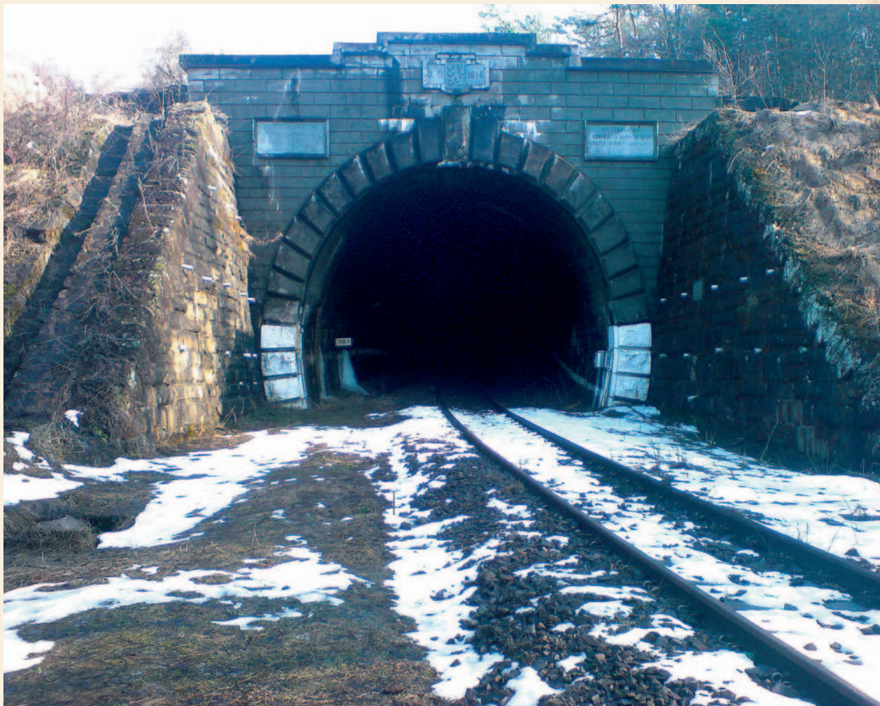
Tunel w Łupkowie
