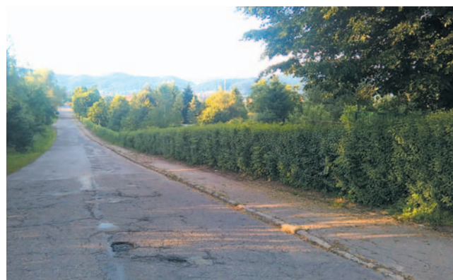
Chodnik po zakończeniu prac...
