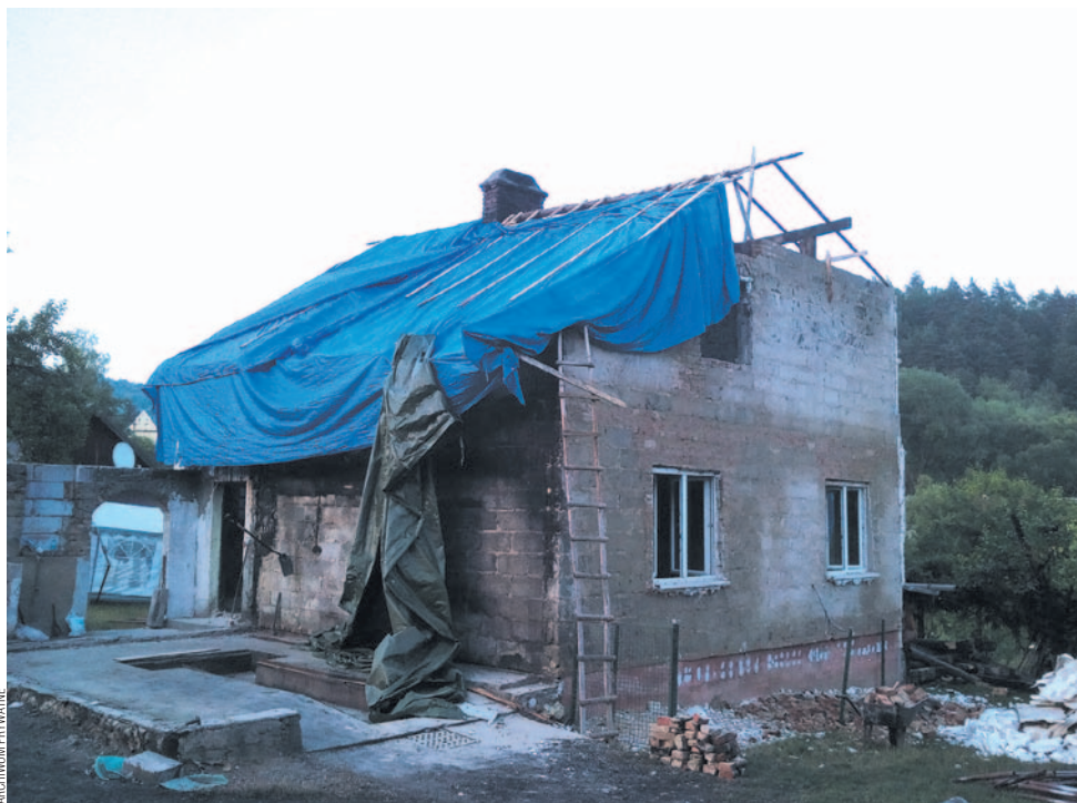
Prace remontowe mogą się rozpocząć niebawem
