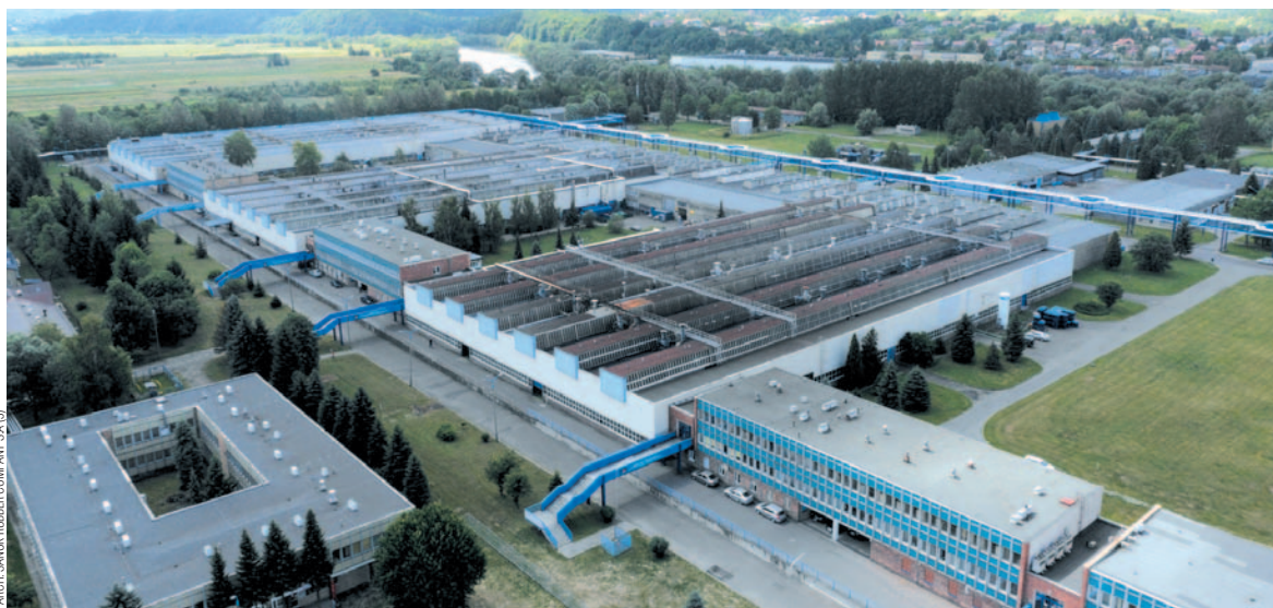
Sanok Rubber Company S.A. – widok z lotu ptaka na prawobrzeżną część zakładów
