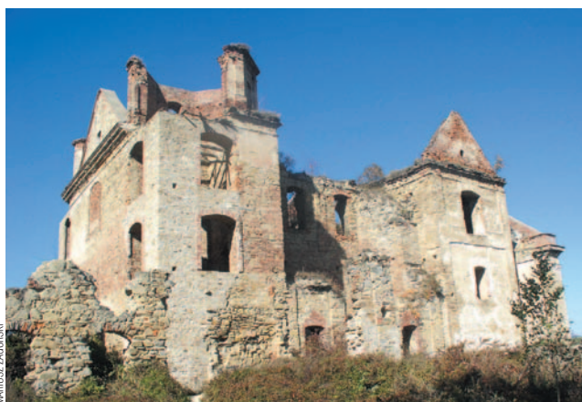
Ruiny klasztoru, stan sprzed remontu
