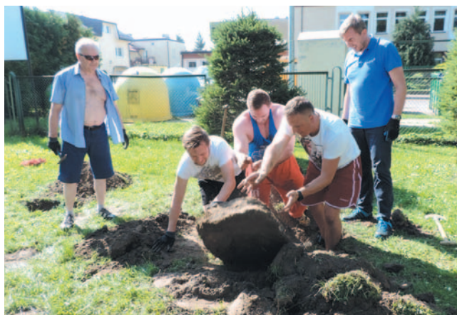
Kopali, betonowali, usuwali z ziemi „kamyki”...
