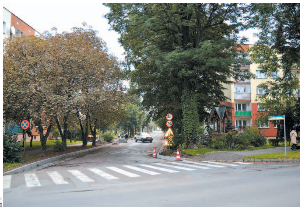
Ul. Armii Krajowej w trakcie przebudowy
