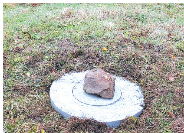
Zabezpieczona studnia nieopodal szlaku turystycznego.
