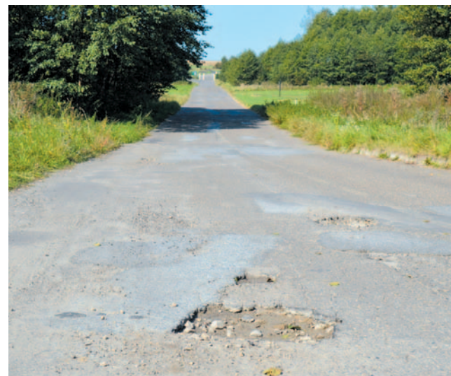
Droga przed remontem
