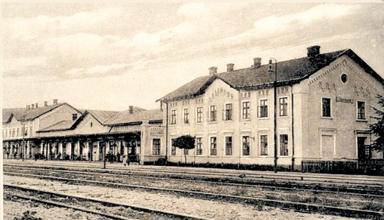
Dworzec kolejowy w Chyrowie w okresie przedwojennym
