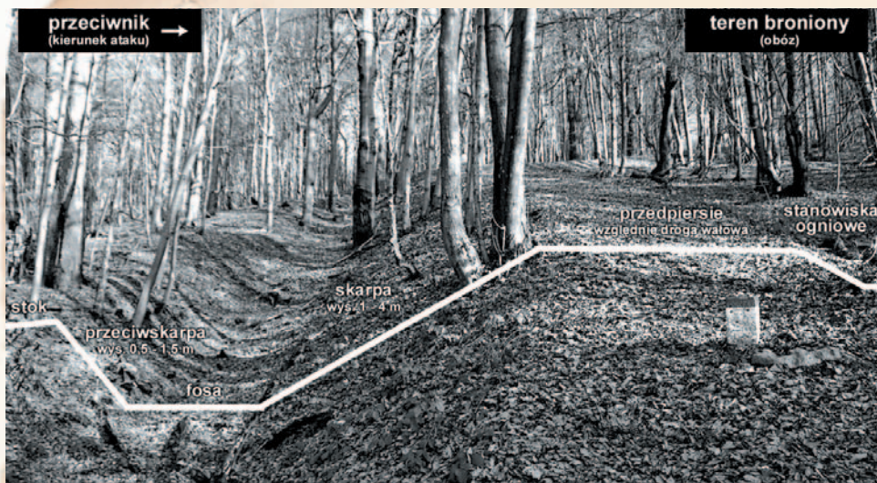
Odcinek umocnień pomiędzy słupkami granicznymi nr 32/7 (na pierwszym planie) i 32/6 z zaznaczonym profilem i opisanymi elementami fortyfikacji (fot. P. Sadowski)
