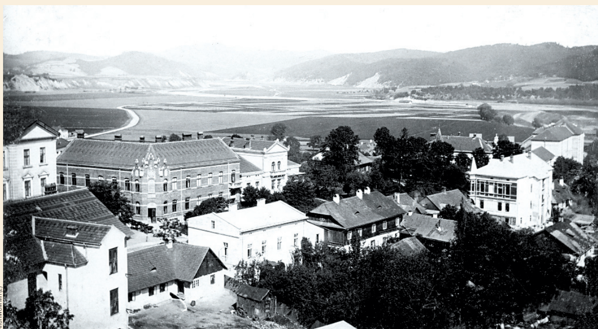
Fotografia przedstawia fragment Śródmieścia. Na pierwszym planie zabudowania przy ul. Sobieskiego. Po lewej stronie widoczna kamienica Władysława Beksińskiego. Środkowa kamienica, z jasną elewacją, była własnością dr. Zygmunta Edelheita – sanockiego lekarza. Poniżej dom rodziny Rudaków i kamienica Filipczaków. Na drugim planie, po lewej stronie, widoczny fragment budynku Gimnazjum Męskiego. Fot. z 1905 r.
