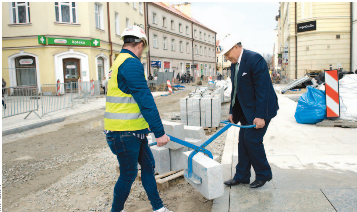
Prezydent Tadeusz Ferenc przy przebudowie ulicy 3 Maja
