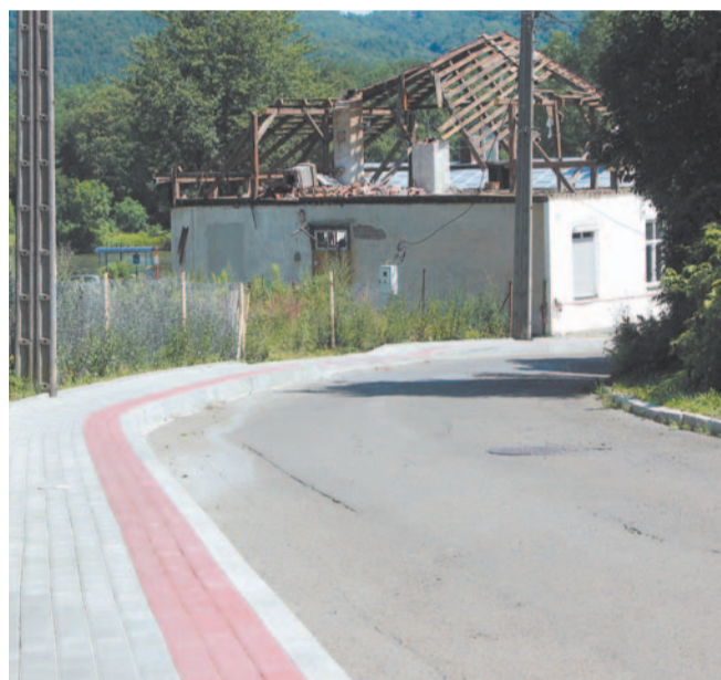
Ulica Sanowa i niebezpieczny łuk, uniemożliwiający widoczność poruszających się aut
