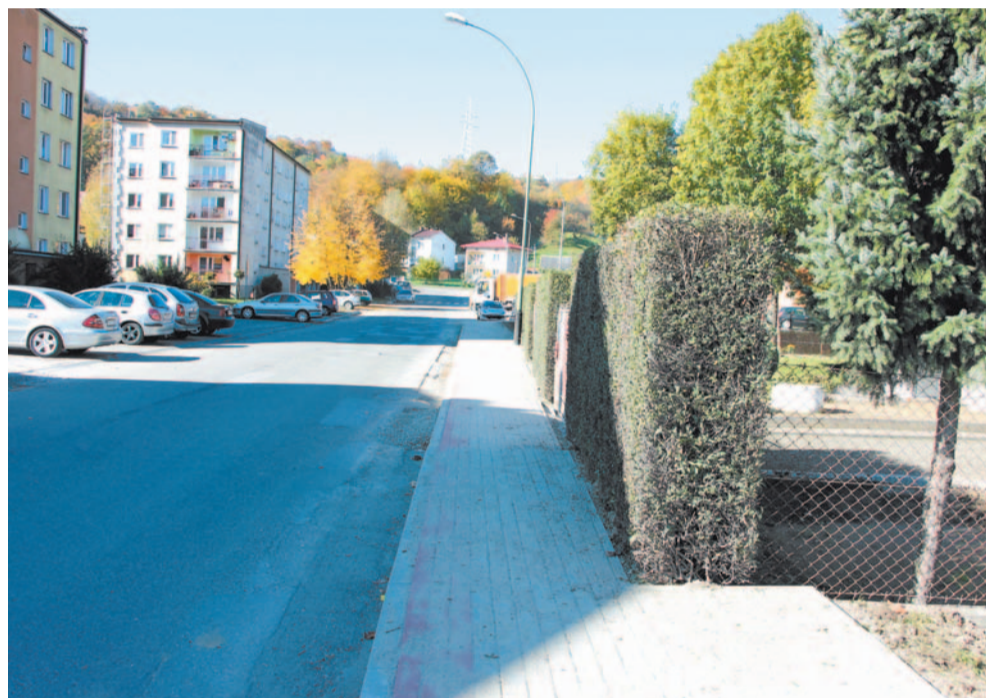
Stan po remoncie chodnika
