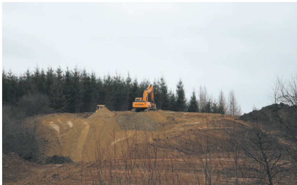
Prace przy fragmencie obwodnicy w okolicach ulicy Okulickiego
