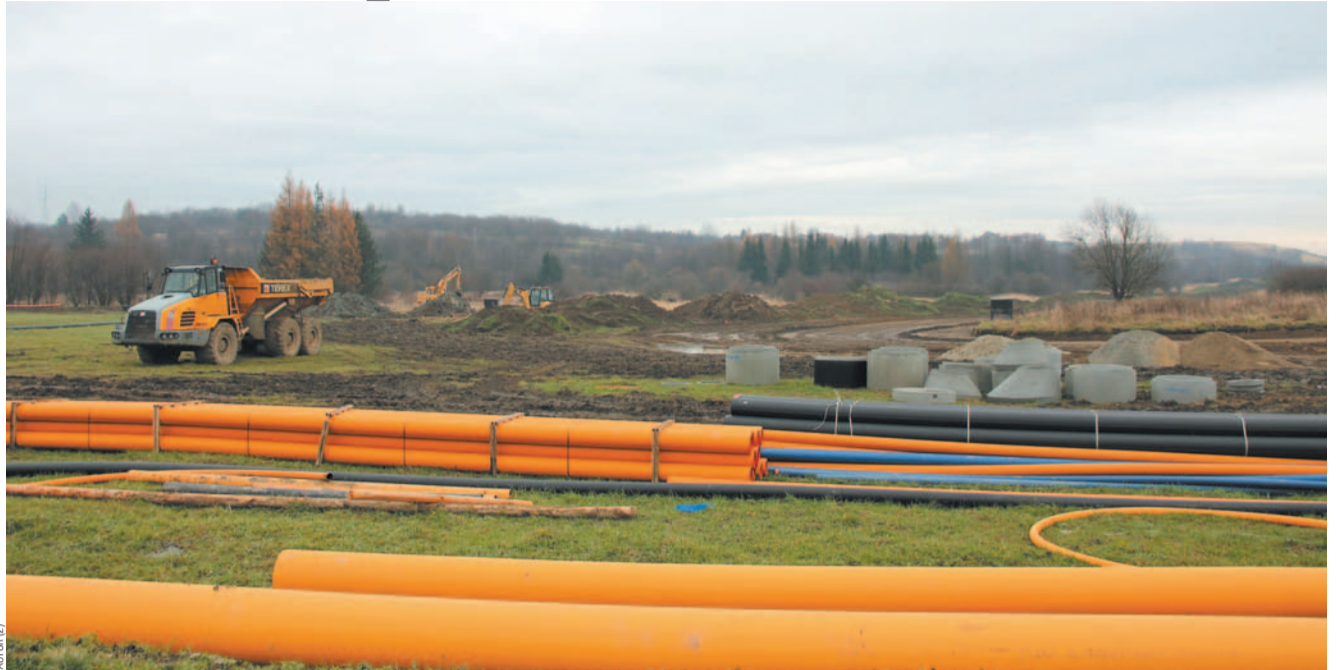
Budowa łącznika do Ronda Beksiańskiego, przy Konopnickiej
