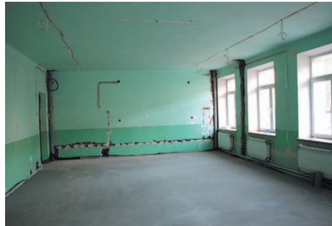
Stan przed remontem
