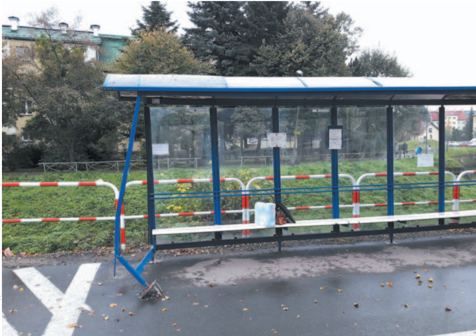
Uszkodzony przystanek na ulicy Podgórze, prawdopodobnie uszkodzony przez kierowcę
