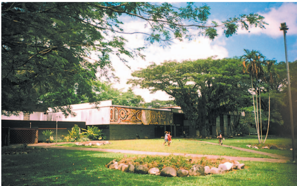
Lae. Politechnika. Budynek socjalny. Fot. T. Barucki
