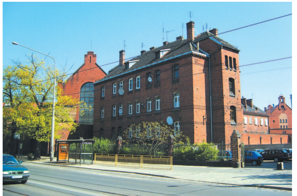
Wrocław. Zakład karny na osiedlu Kleczków.
