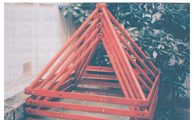
Płock. Elementy struktury na placu budowy. Fot. T. Barucki
