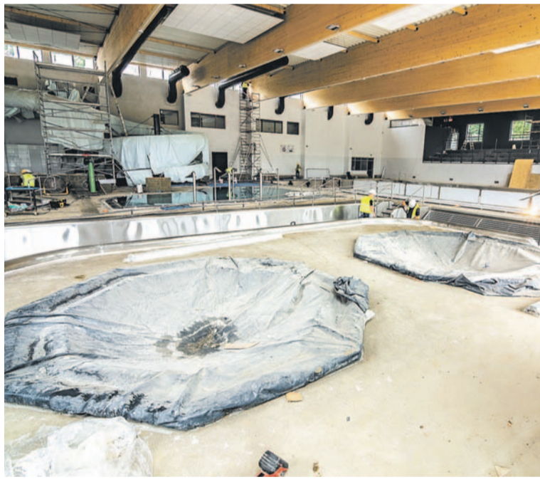
Woda jest już w pierwszej niecce rekreacyjnej, a także w rehabilitacyjnej i w brodziku. W basenie sportowym trwa montaż ruchomego dna.
