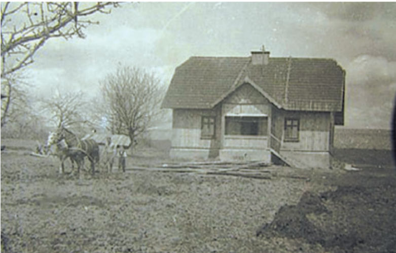
Czarna PGR, budynek, w którym mieszkał Lesław wraz z rodziną. Zdj. zrobione od strony obór, gdzie nocowały krowy PGR.
