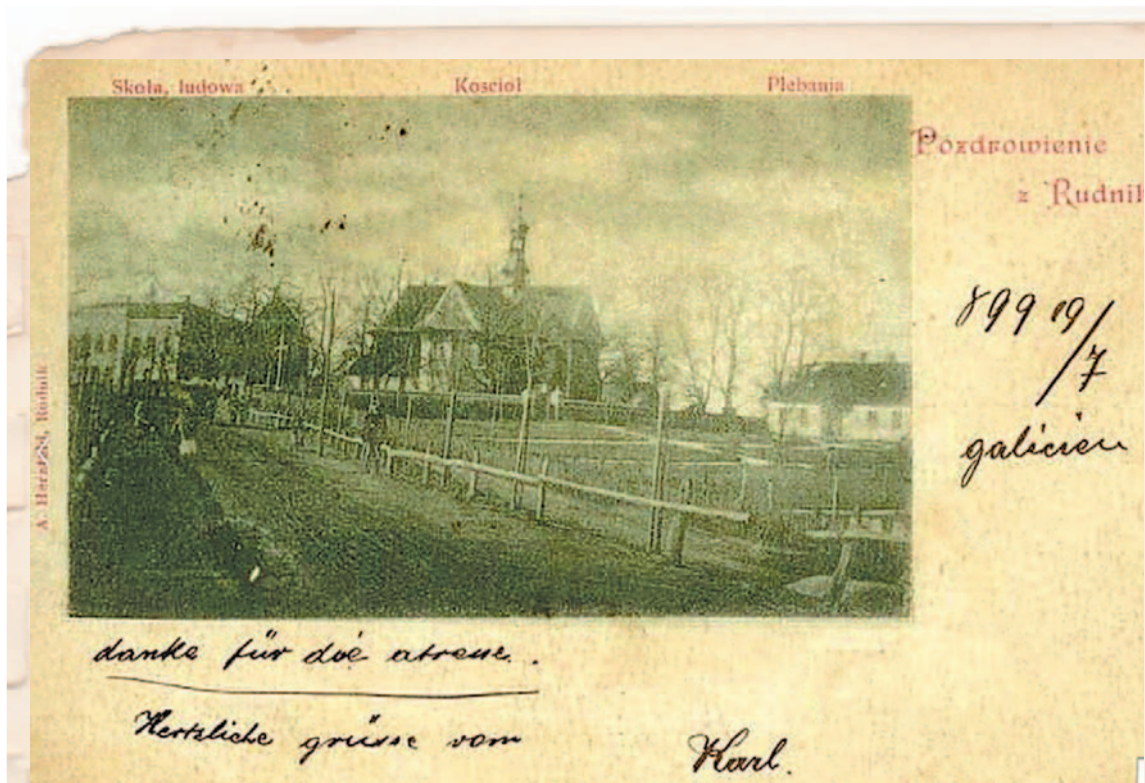
Rudnik nad Sanem na pocztówce z 1899 roku.
