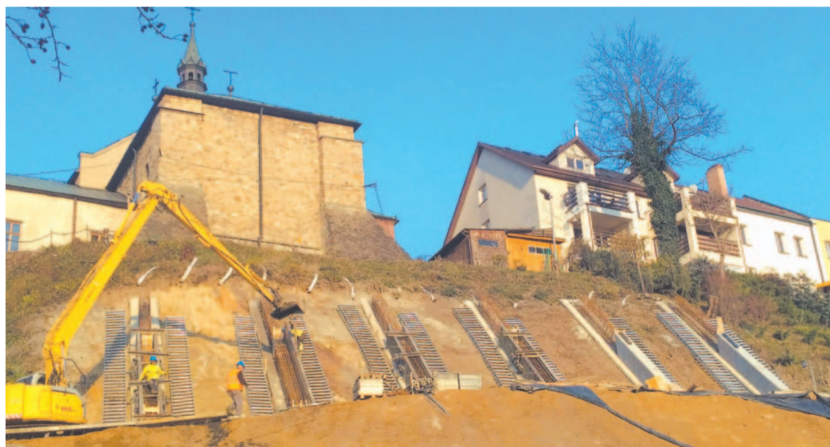
Prace zabezpieczające osuwisko poniżej Rynku nad ul. Podgórze
