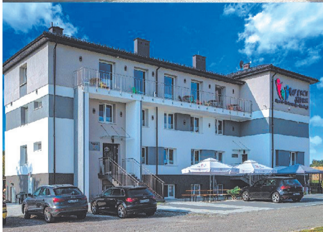
Klubowy budynek przed remontem i w chwili obecnej
