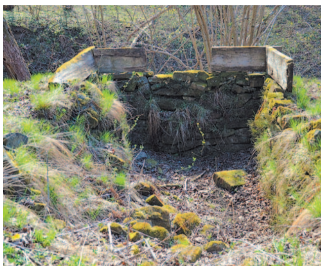
Choceń – pozostałości zabudowań, fot. Lidia Tul-Chmielewska
