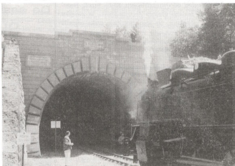
Postój przed wjazdem do tunelu
