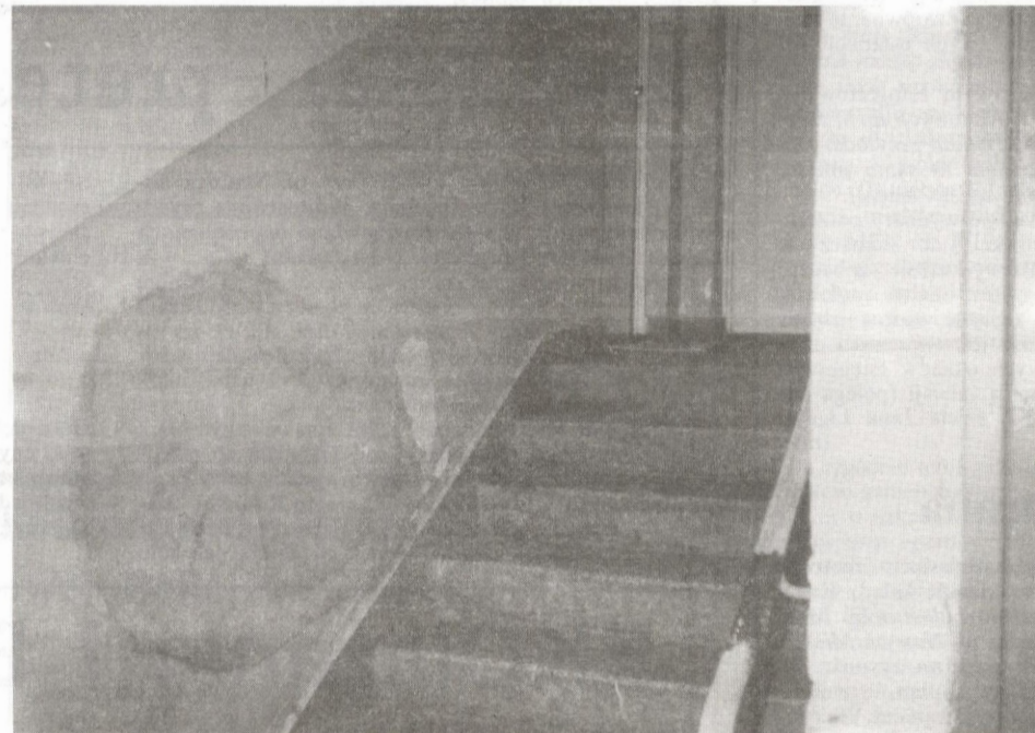
Klatka schodowa w jednym z bloków.
