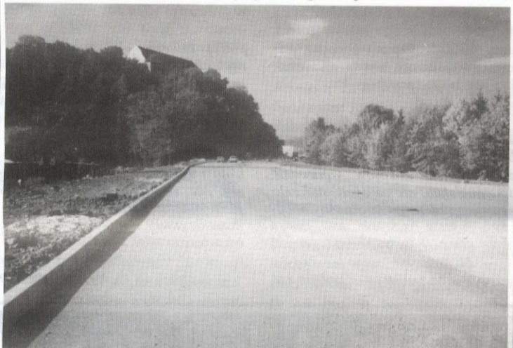
Jeszcze tylko warstwy bitumiczne.
