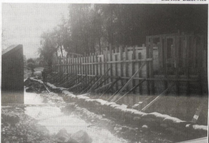
To nie byle kładka, a potężny most.
