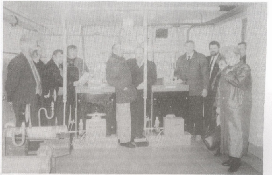
Kotłownia w dniu oddania do użytku.
