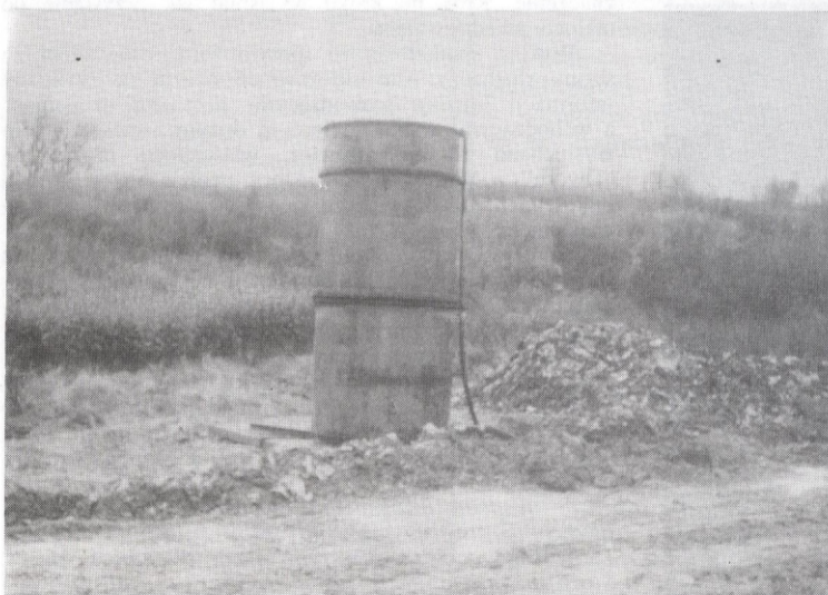
W tym wielkim zbiorniku gromadzone są odcieki. Następnie beczkowiec zabiera je do Oczyszczalni Ścieków.
