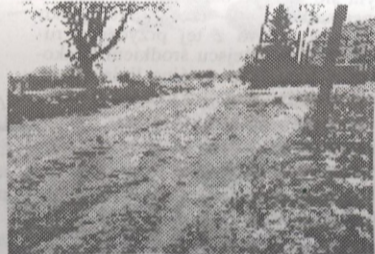
Droga przypomina zamrażnięty potok.
