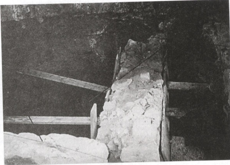
Fragment sklepienia w dolnej partii wieży
