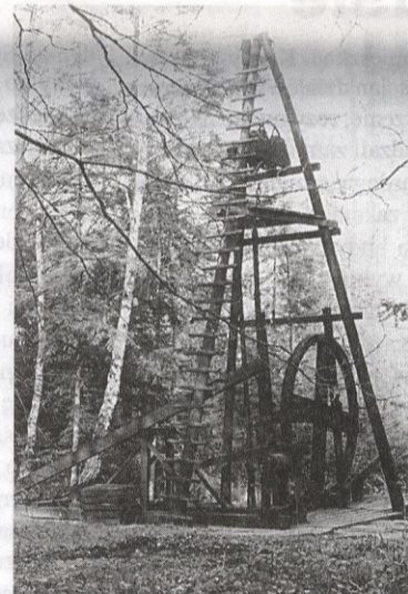
Bóbrka – Skansen. Wiertnica do ręcznego wiercenia udarowego z 1862 r.
