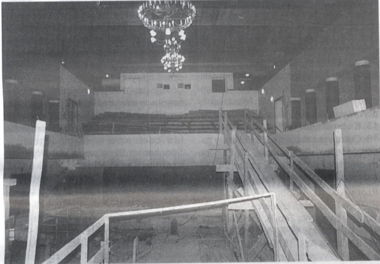
Całe wnętrze SDK-u jest jednym wielkim placem budowy. Fot. Archiwum SDK.
