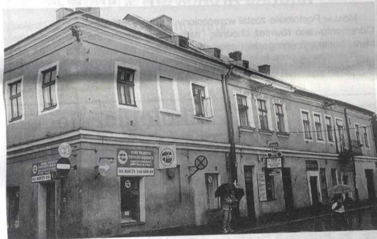
Te kamienice mogą zniknąć z sanockiego pejzażu
