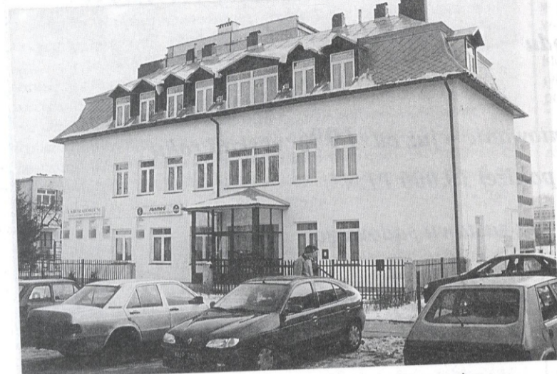
Właściciele SANMEDU już myślą o rozbudowie obiektu. Fot. St. Żyłka.
