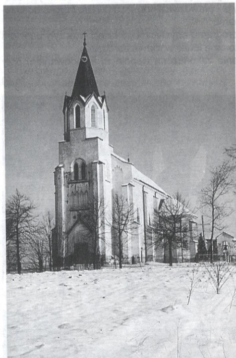
Kościół w Dudyńcach (zbudowany w 1876 r.)
