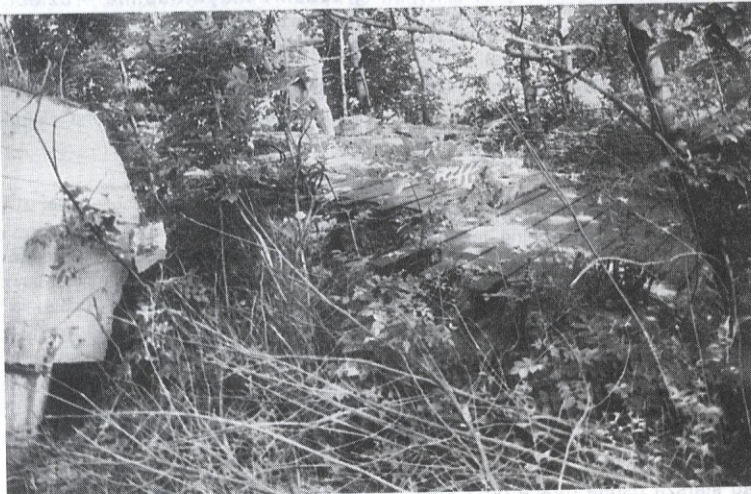
Fragment zbrojenia dachu (zbrojenie wewnętrzne) – Olchowce.
