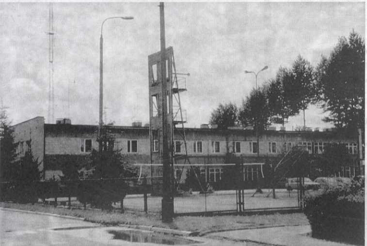
Sanockim strażakom nie pracuje się łatwo – postomilowski budynek jest zawilgocony, kosztowny w eksploatacji i źle usytuowany.
