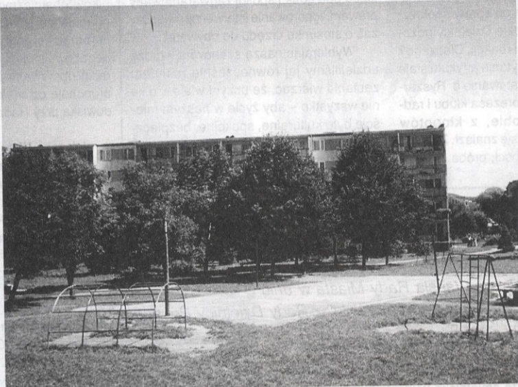
Osiedle Traugutta III. W przeciwieństwie do większości bloków, ten posiada od niedawna nową instalację odgromową. Na nim też zakończono ocieplenie tutejszych bloków. Dla części mieszkańców to dowód na interesowność prezesa SSM Stanisława Milczanowskiego, który w tymże bloku mieszka.
