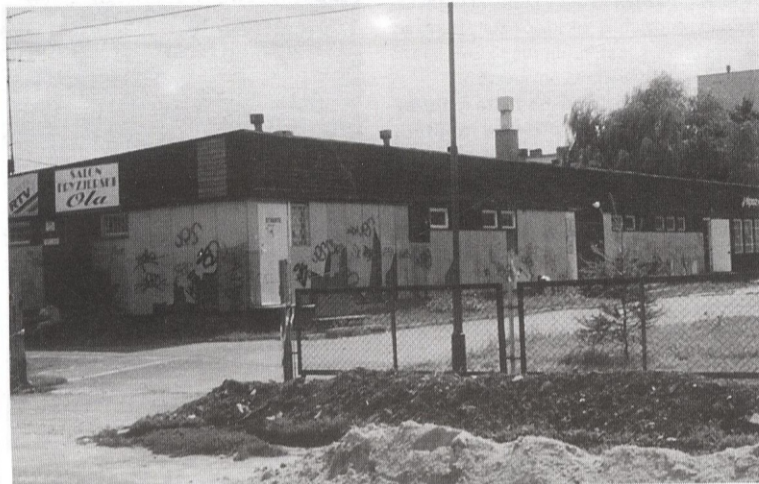
Budynek pechowego klubu przy ul. Kwiatowej.
