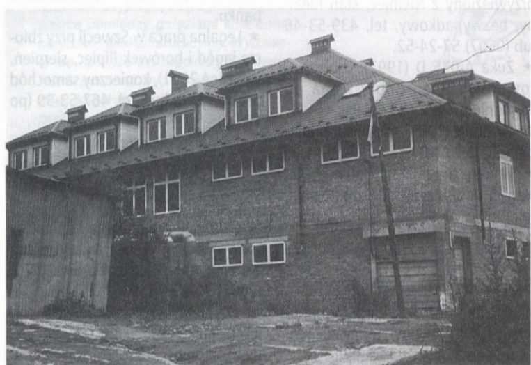
Obok szpitala wyrósł budynek nowej stołówki. W ubiegłym roku udało się również „wyprowadzić” ze szpitala stację trafo.
