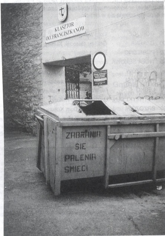
Skąd się wzięły pęknięcia na murze?
