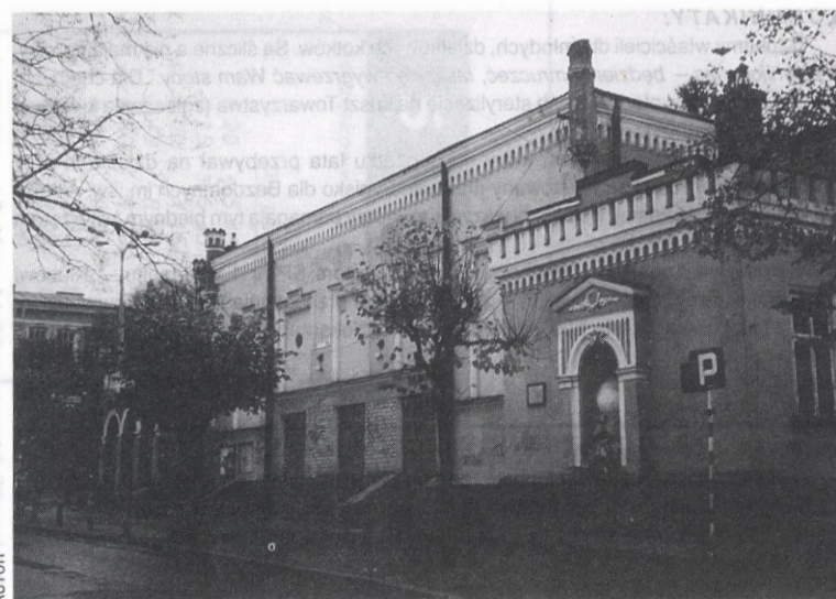
Konieczny generalny remont.
