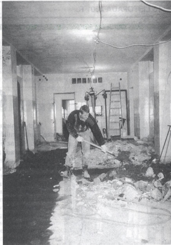
Część przychodni przy ulicy Lipińskiego zamieniła się w prawdziwy plac budowy. Wykonawcą prac jest firma TOMA.
