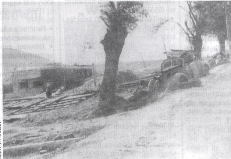
Słowacka kolumna zniszczona pod Załużem – z widocznego rosyjskiego bunkra.
